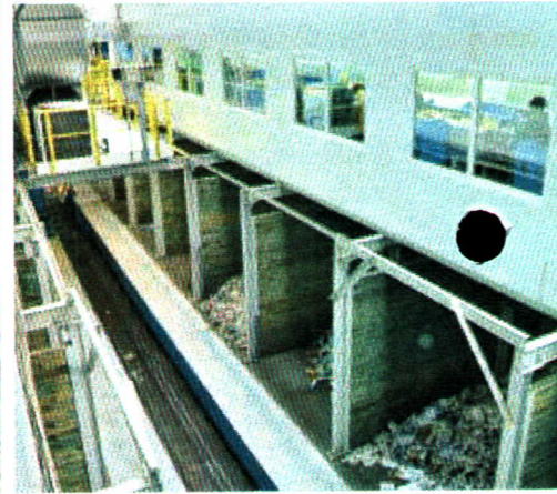
ZUOK RADOM – boksy zsypane na wysortowane surowce wtórne
