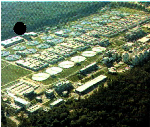
Oczyszczalnia Ścieków „Czajka” w Warszawie
