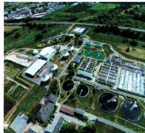
Miejska Oczyszczalnia w Siedlcach po rozbudowie i modernizacji w 2014 roku
